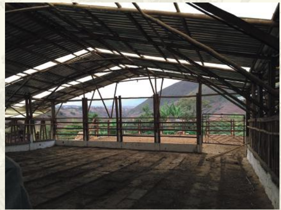
Detalle del piso
