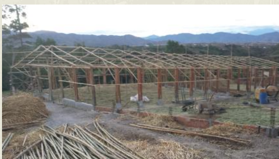
Detalles de la estructura del techo.
