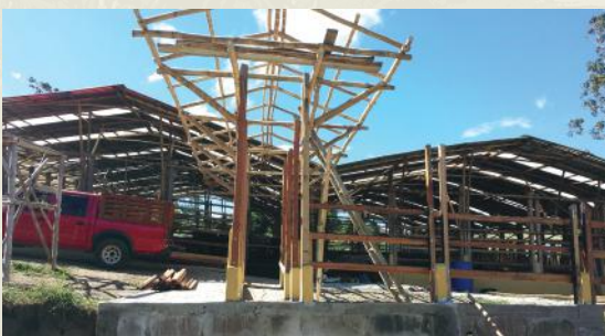
Construcción del apretadero y embarcadero
