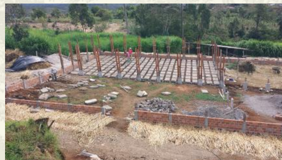
Construcción del establo
