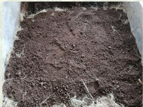
Colocación de la capa de tierra negra
