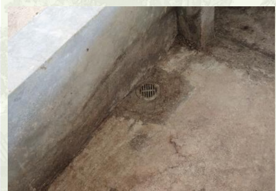
Detalle del piso de cemento, paredes y sifón de drenaje.
