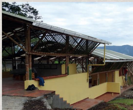
**Canaletas y conducción al tanque de aguas lluvias**
